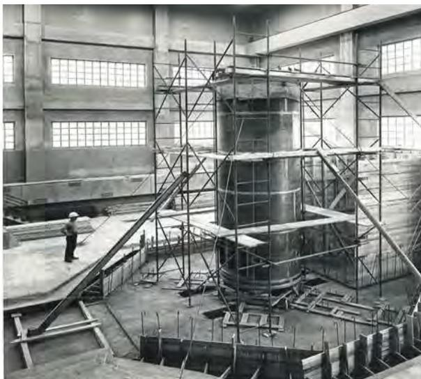
Figura 2: Installazione del tank in alluminio del reattore che ospiterà il nocciolo.
